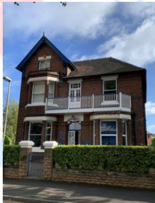
Nasze nowo wyremontowane biura; Zdjęcie dzięki uprzejmości M. Rai, IPA UK
